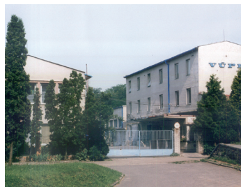
pracoviště Hrušovany n.J. / premise Hrušovany n.J.
