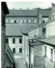
pracoviště Praha 5-Smíchov / old premises Prague 5
